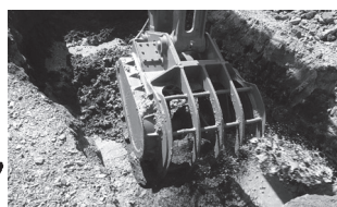
地盤改良材と土をバケツ ミキサーで混ぜる
