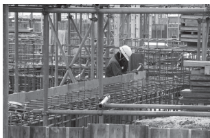
型枠の取り付け作業
