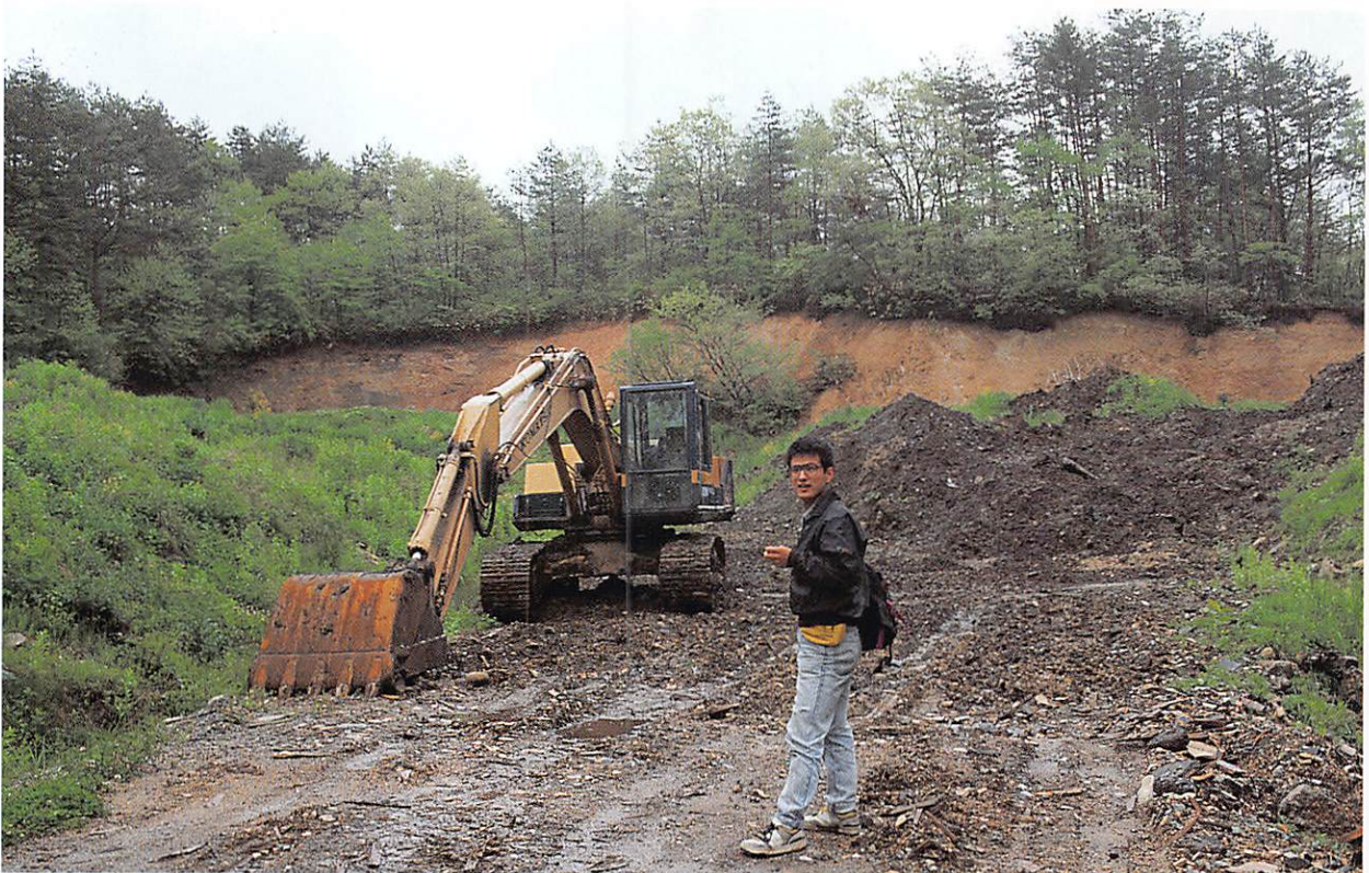
写真6 長者原湿原に土砂を流入させ、湿原の陸化を促進させたと考えられる土取り場。1992年5月23日撮影
