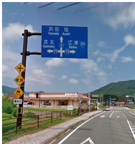
景観に配慮された茶系の色彩の支柱
