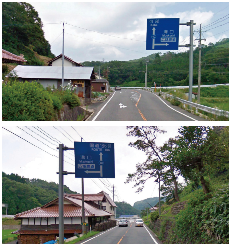
図：広域農道と表記された108系標識
