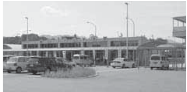
▲道の駅舞口ロードIC千代田は「過疎債」を活用し建設しました
