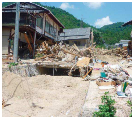
土砂の堆積状況
