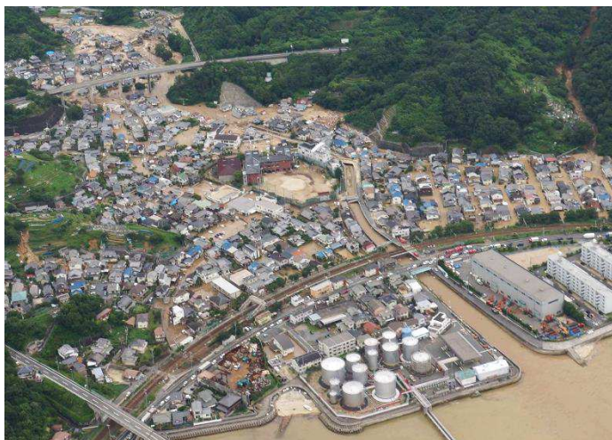
安芸郡坂町小屋浦
