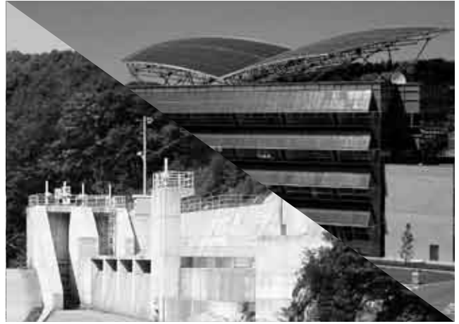
川小田小水力発電所④と役場庁舎太陽光発電システム
