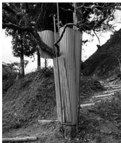
設置されたトタン巻き
