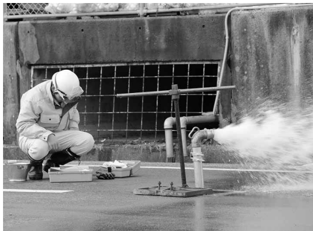
▼ブロック割をしたうえで試験通水を 繰り返しながら復旧作業を進めていきました
