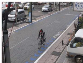
写真 I-6 車道左側部の車線内に矢羽 根型の路面表示を設置した事例 (歩道 のない道路)
