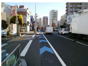
写真 I-4 車道左側部の路肩内に矢羽根型の 路面表示を設置した事例
