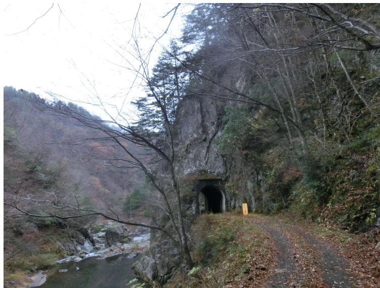
図 1-2 北広島町が管理するトンネル
