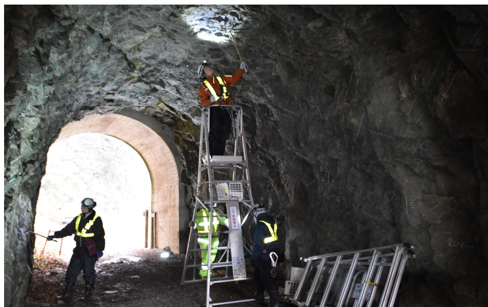
図 1-3 トンネル定期点検状況（令和元年度）
