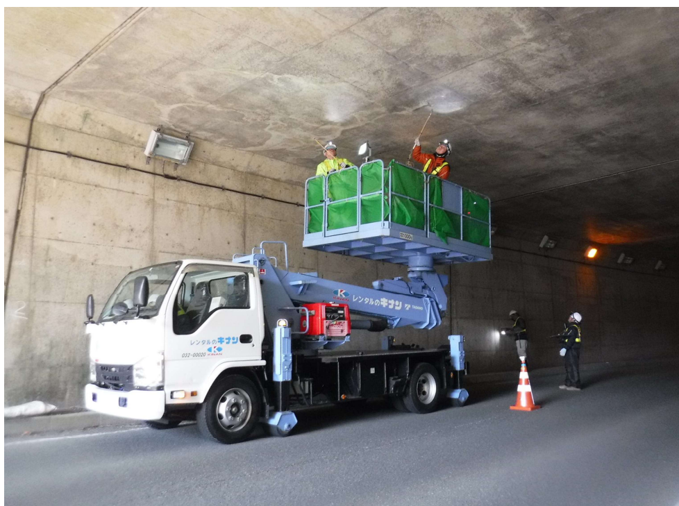
図 2-1 大型カルバート定期点検状況（令和元年度）
