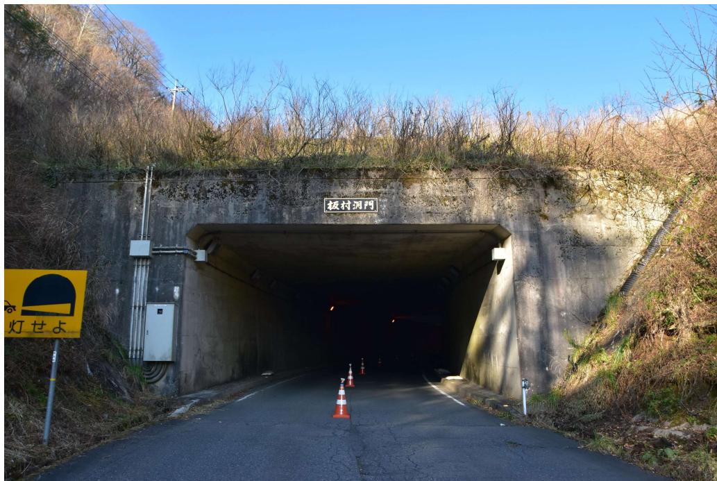
図 1-2 北広島町が管理する大型カルバート
