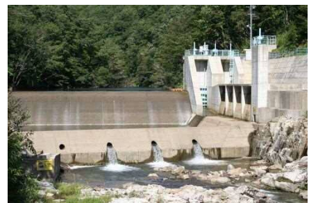
川小田小水力発電所
