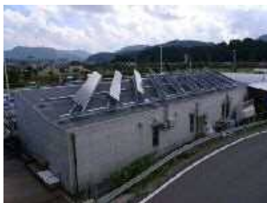
道の駅 舞ロードIC千代田 太陽光発電パネル
