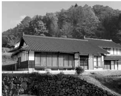
石州瓦葺きの屋根が美しい住宅（前景）
