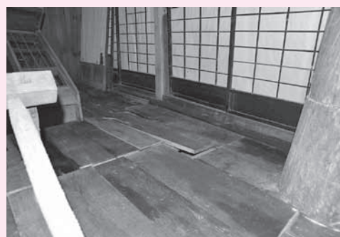
◀修復前の古民家の床材
