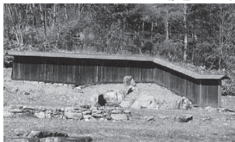
完成した板塀
