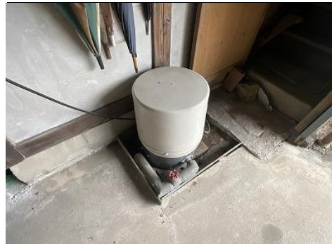
井戸ポンプ設置状況
