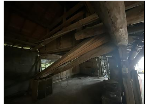
納屋1階 梁状況
