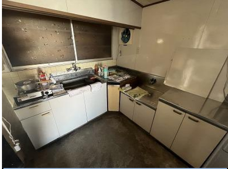
台所（土間）流し廻り
